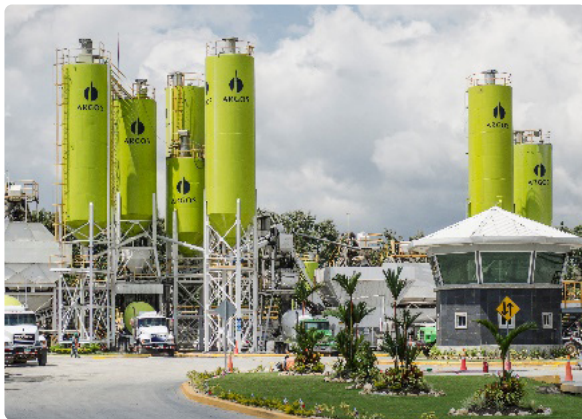
Tocumen Concrete Plant, Panama (Cementos Argos)
